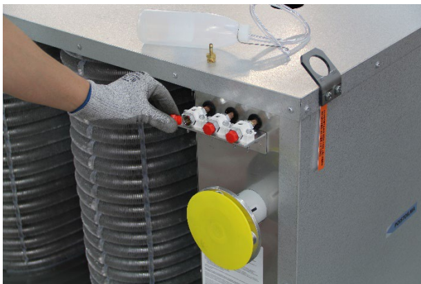
Ta bort skyddslocket från luftningskranen.
