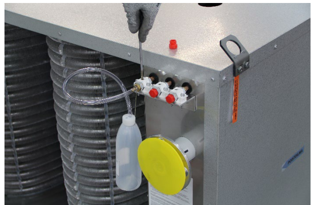
Öppna luftningskranen lite, så att luften kan komma ut från värmeåtervinningsanordningen.
